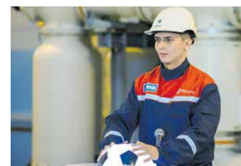
Волнующий момент: дежурный по ПС «Пресня» Константин Горинев запускает работу подстанции
