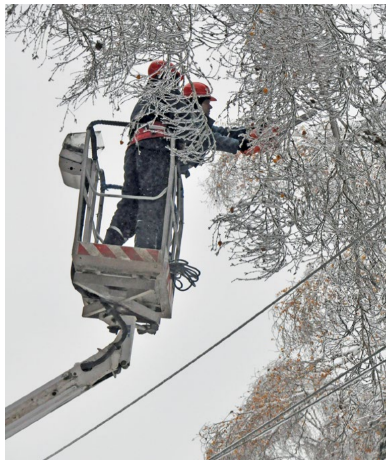
Электрики «Челябэнерго» во время ликвидации последствий ледяного дождя
