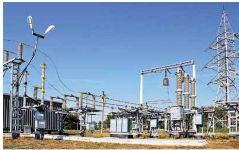
ПС-110/35/6-10 кВ «Уваровская», введенная в эксплуатацию в 1975 году. Мощность подстанции составляет 42 МВА. ПС «Уваровская» является узловой, обеспечивает электроэнергией часть Жердевского, Уваровский и Мучкапский районы.
