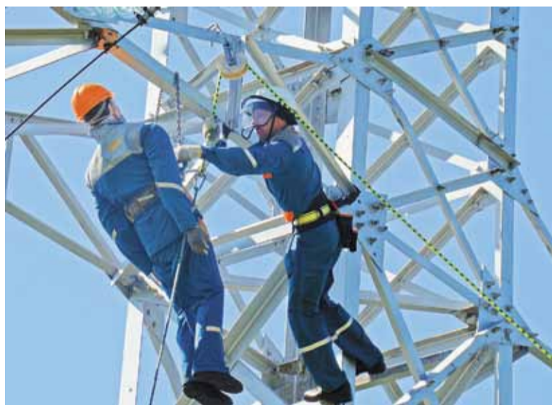
Электромонтеры снимают пострадавшего с опоры
