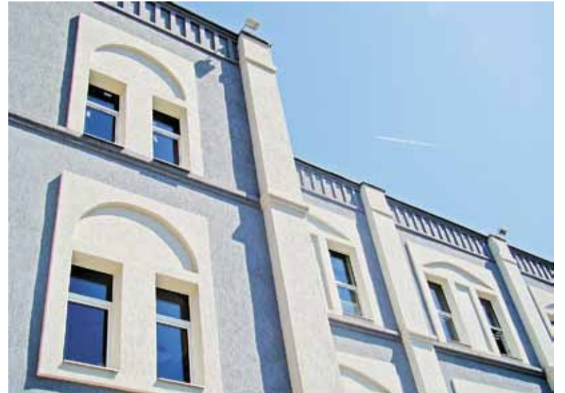
Подстанция 110 кВ «Центральная»
